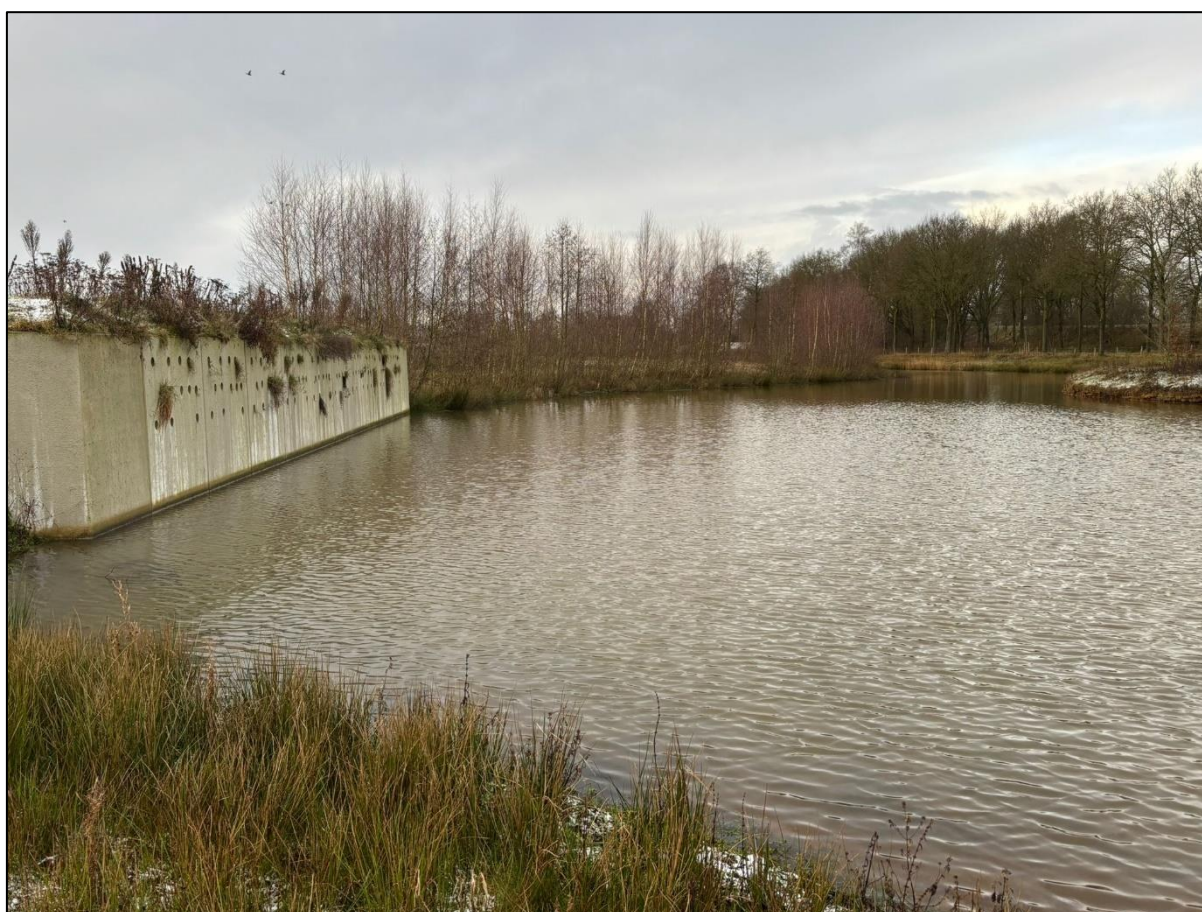
Nieuwe oeverwaluwenwand in winterrust. December 2025. Foto: GJvD.
