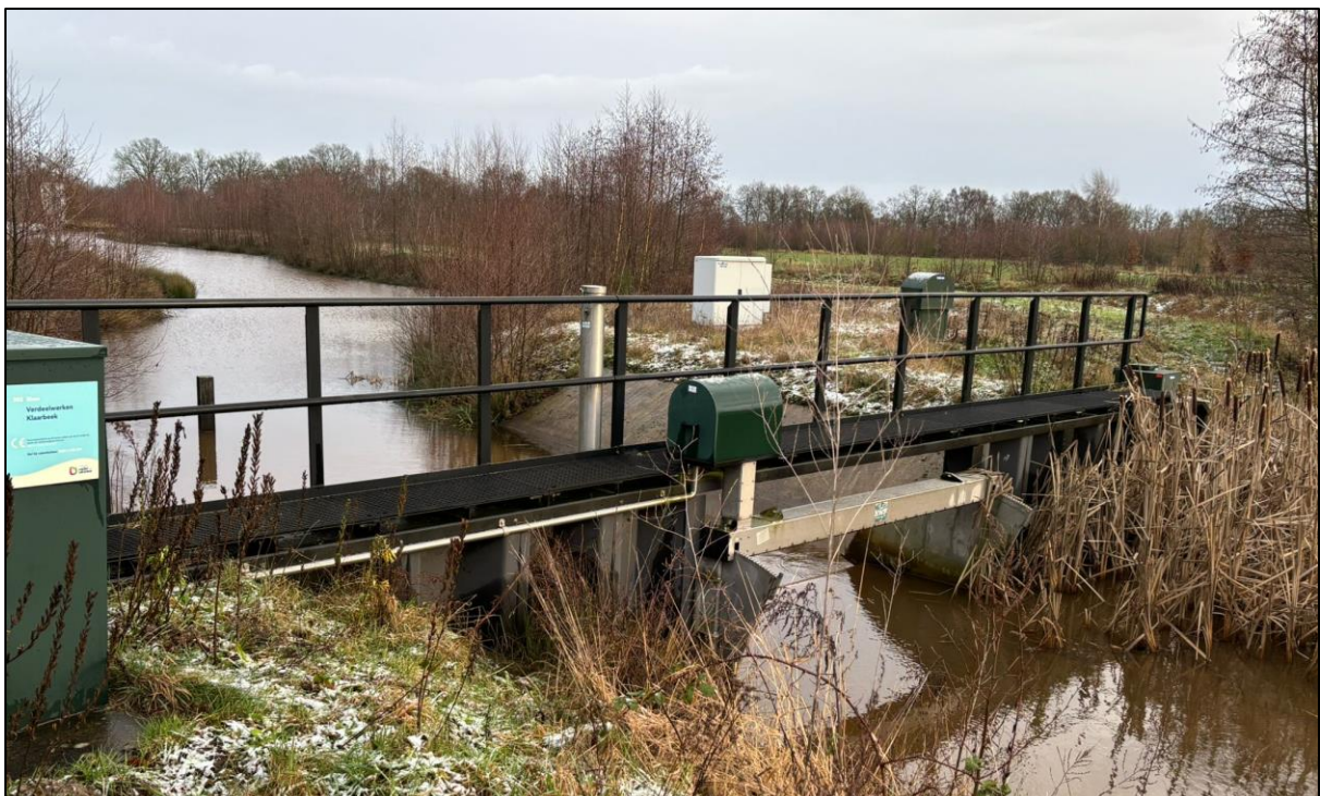
Water uit de Klaarbeek bereikt het innamepunt aan de Vossenbroekweg in Zuuk. Foto: GJvD.
