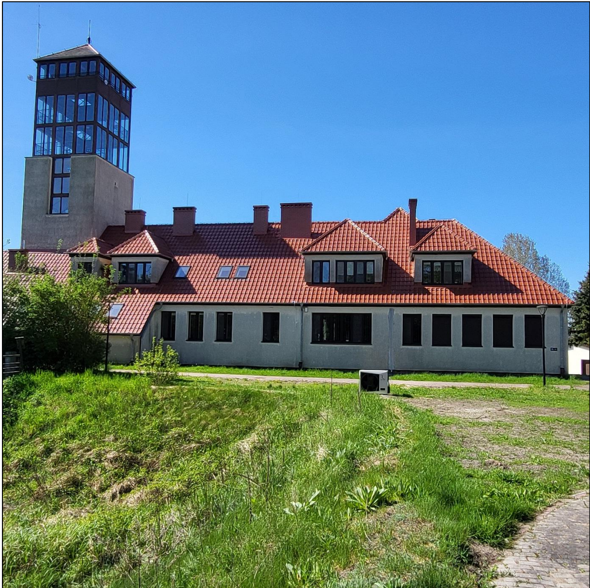
Kantoor Nationaal Park Ujście Warty . Gebouw voor publiek gesloten en wordt in 2025 nog gerenoveerd. Foto: AH.
