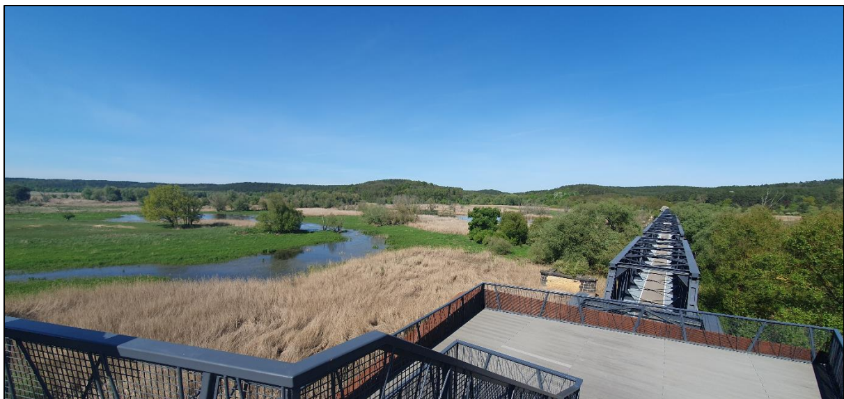
Blick von der kürzlich renovierten Eisenbahnbrücke bei Siekierki. Das Reich aller erdenklichen Sumpfvögel! 28. April 2025. Foto: GP.
